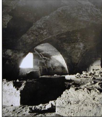
(لوحة رقم ١١) السبع قاعات - الدور الثاني (عناصر إنشائية) عقود - أقبية متقاطعة -
