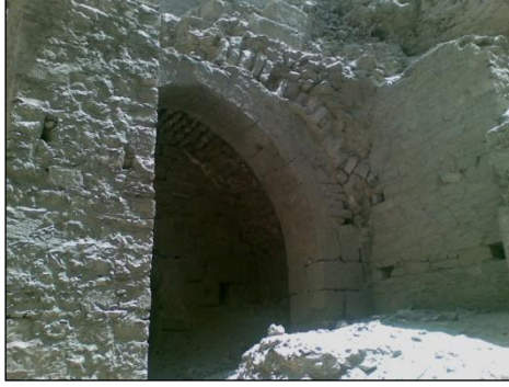
( لوحة رقم ١٥ ) عقود وأقبية ودعامات بالطابق الثاني
