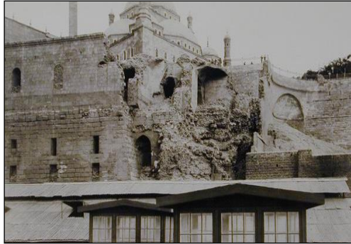
( لوحة رقم ٨ ) السبع قاعات والأجزاء المتهدمة في الركن الجنوبي منها قبل ترميم سنة ١٩٦٥م - المجلس الأعلى للآثار
