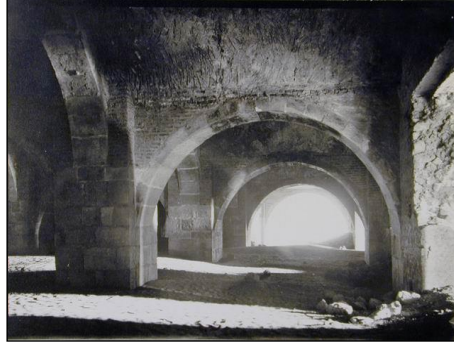
( لوحة رقم ١٢ ) السبع قاعات - الدور الثاني ( عناصر إنشائية ) عقود - أقبية متقاطعة - دعامات
