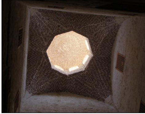
( لوحة رقم ٢٨ ) قيو مروحي تتوسطه فتحة مثمانية قلعة قايتباي بالإسكندرية
